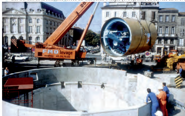
Les travaux de la conduite forcée du Caudéran-Naujac (1986), mise en service en 1989.
