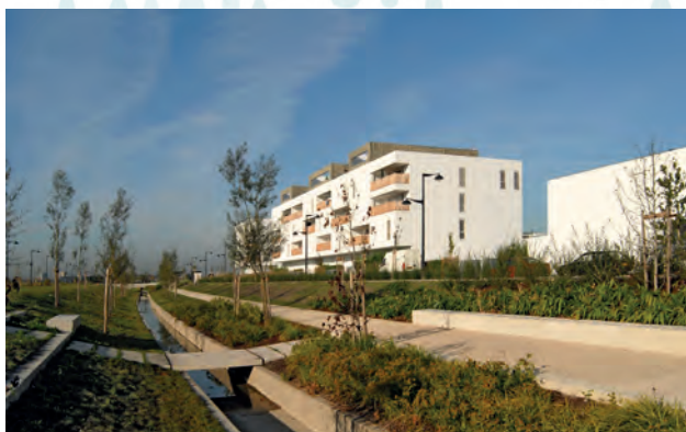
Canal de rétention des eaux pluviales, ZAC des quais à Floirac.
