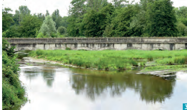
Au Taillan-Médoc, portion de l'aqueduc reliant le Thil-Gamarde au réservoir central (rue Paulin) à Bordeaux.
