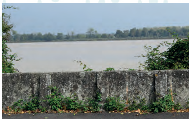
Digue de protection sur la presqu'île d'Ambès.
