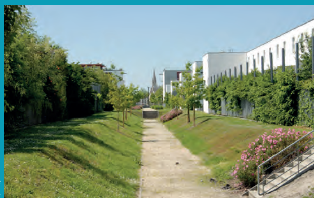
Aménagement d'une zone de rétention des crues de la Garonne faisant également office de cheminement piéton, quartier de La Bastide à Bordeaux.
