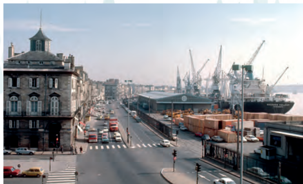
Dans les années 1970, les grilles érigées sur les quais pour séparer le port de la ville existaient encore.
