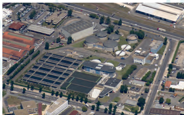
Station d'épuration Louis-Fargue à Bordeaux.
