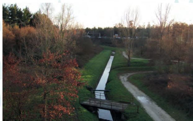
Le Guâ canalisé à Lormont.
