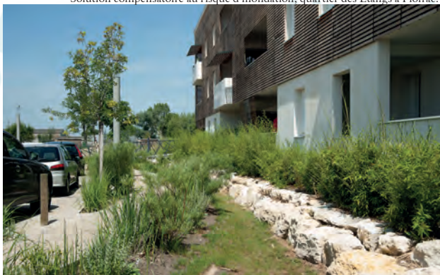
Solution compensatoire au risque d'inondation, quartier des Étangs à Floirac.
