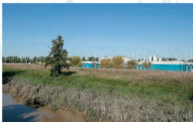
Station d'épuration Clos de Hilde à Bègles.
