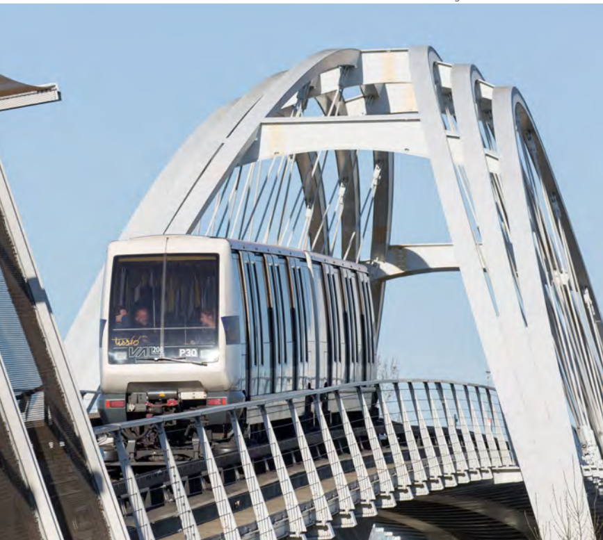
Toulouse, rame de VAL 208 NG sur le viaduc des Argoulets. © Pierre Barthe
