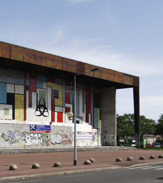
La mosaïque restaurée sera réinstallée en façade du nouvel édifice.
