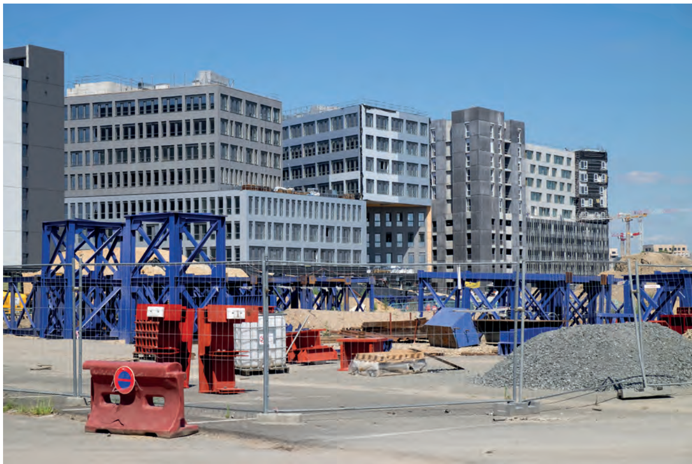
Travaux sur le territoire de l'Opération d'intérêt national Bordeaux-Euratlantique.
