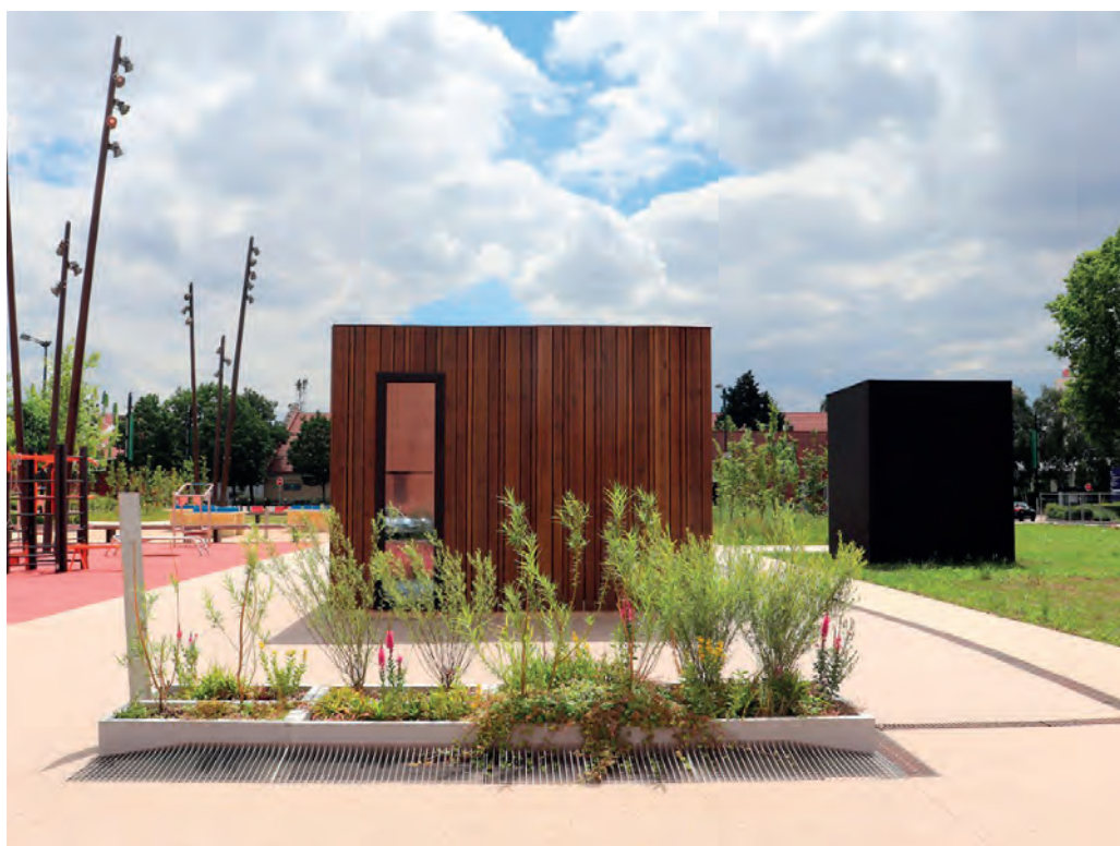
Aménagement paysager modulaire de gestion des eaux pluviales et d'apport de biodiversité en milieu urbain. © Élodie Stephan.
