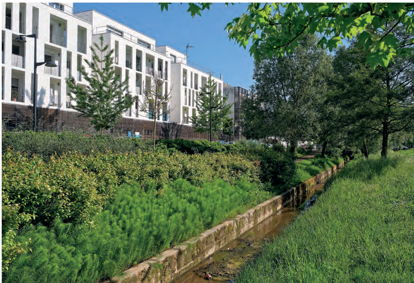
La noue paysagée, un espace public loulvert, arboré et filtrant de 800 m de long au cœur de la ZAC des Quais à Floirac.
