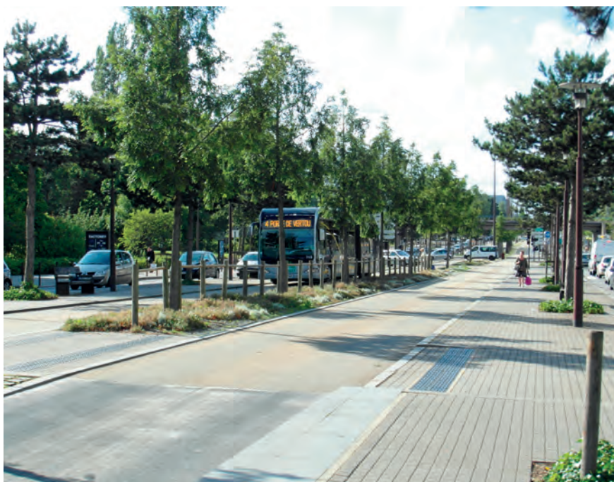
À Nantes, un espace public arboré et aménagé « à niveau » autour de la ligne 4 de BHNS, © Ingolf, source Flickr.
