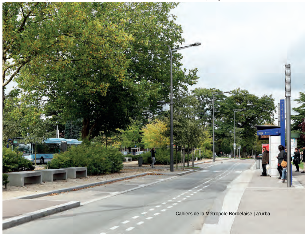
À Rouen, le guidage optique du TEOR permet une emprise minimale de la chaussée, © agence D&A.
