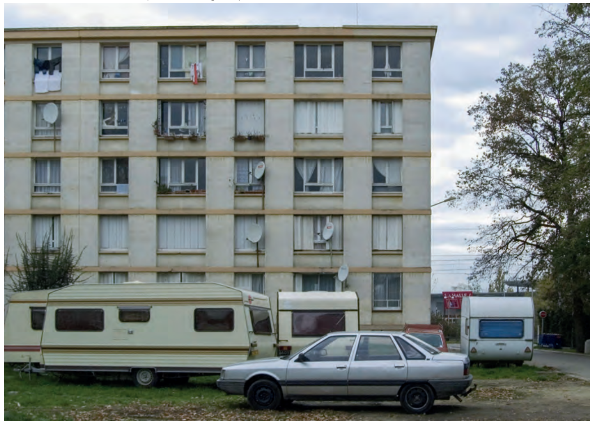
La cité des Ruaults à Sainte-Eulalie, démolie en 2013 - 2014.
