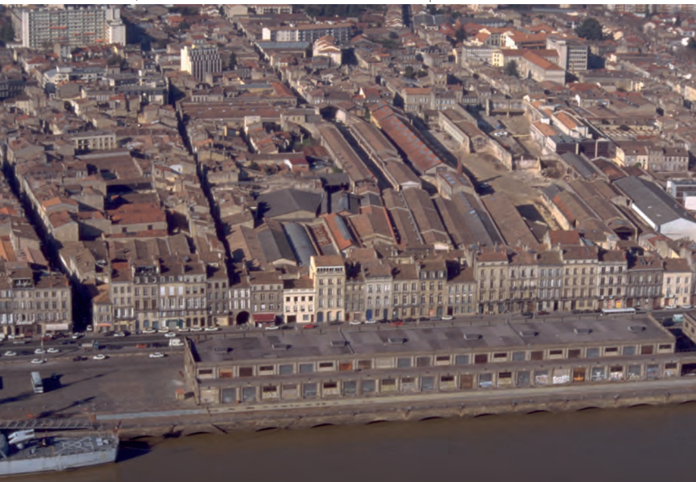
Vue de la rive gauche au milieu des années 1990 : au premier plan, le hangar démolí a laissé place à un skatepark ; à l'arrière, la ZAC des Chartrons a été construite en actualisant le patrimoine des chais et son tissu urbain en laníères.
