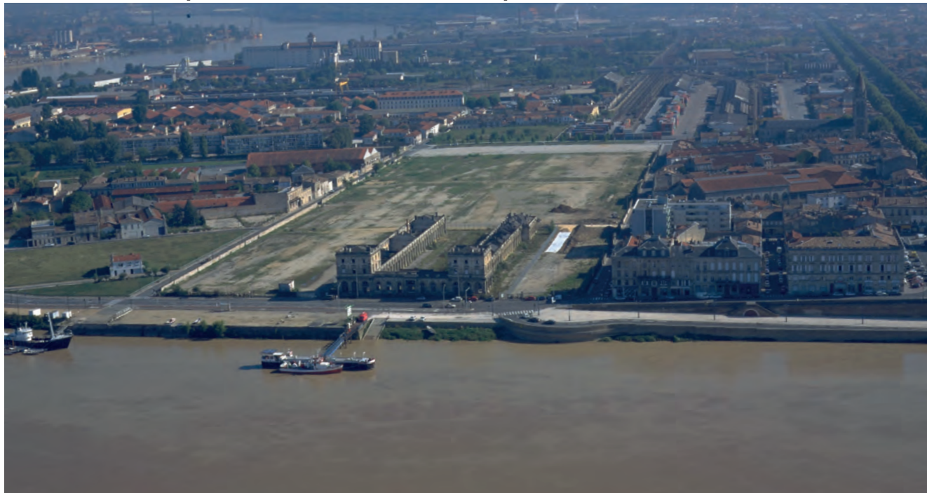
Vue de la friche ferroviaire de la gare d'Orléans au milieu des années 1990 où sera aménagée la ZAC Cœur de Bastide.
