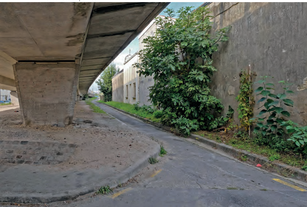
Sous-face du pont Saint-Émilien à Cenon.
