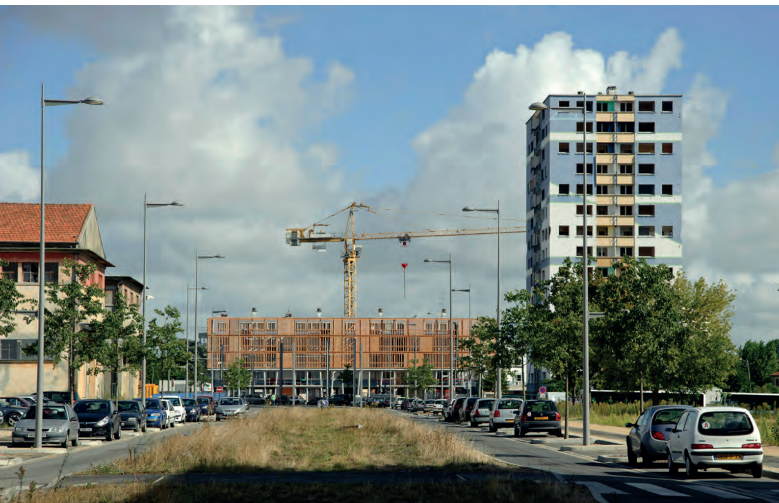
Le quartier des Terres-Neuves en septembre 2010, la tour E de la cité Yves-Farge sera démolie le mois suivant.
