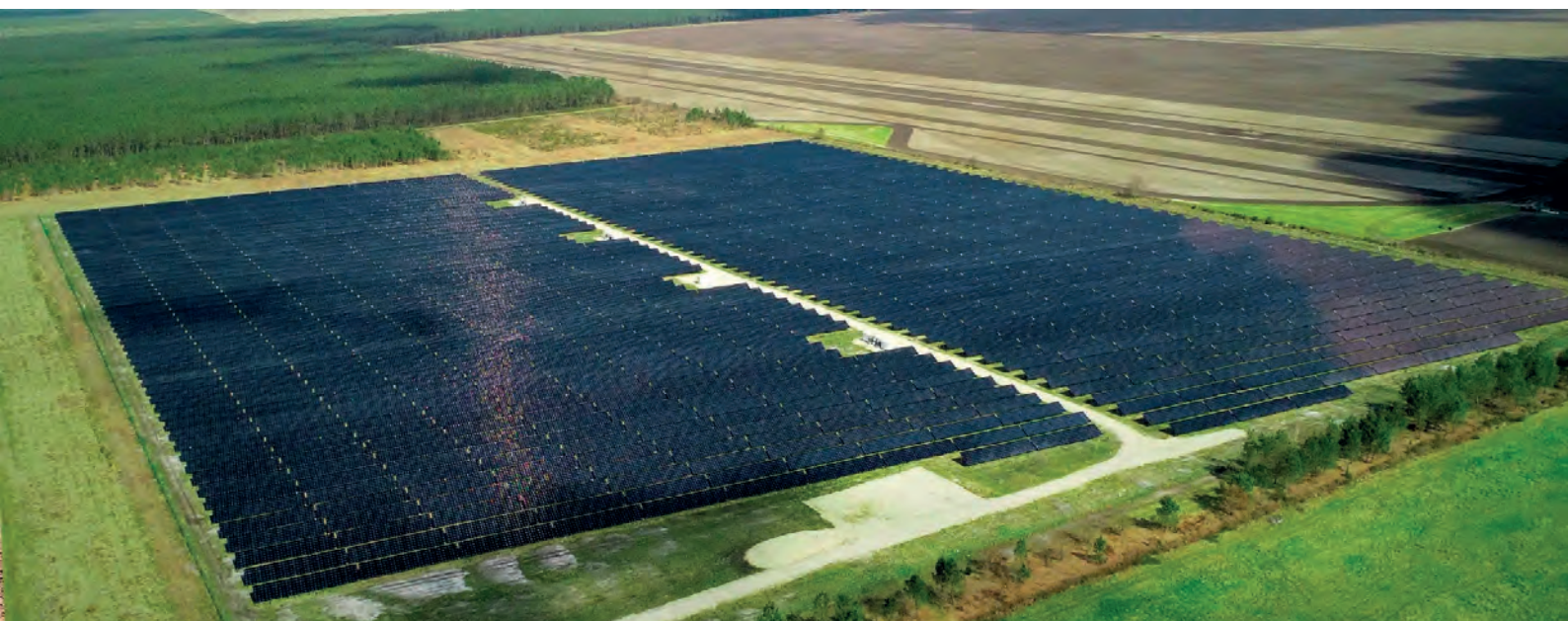
Parc photovoltaïque de Lugos. © neoen.
