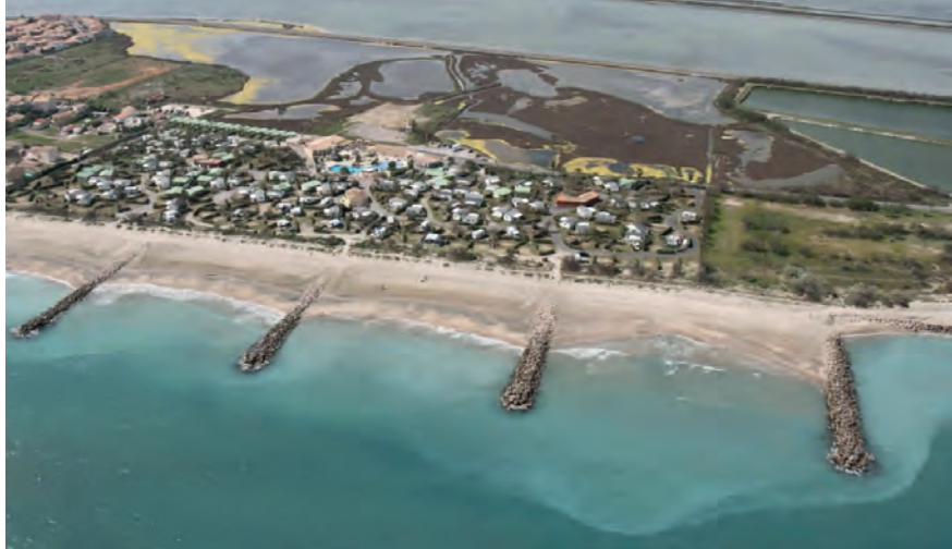
Des épis pour lutter contre l'érosion à Saint-Cyprien. Extrait du film Entre mer et terre . Réalisation : Hervé Colombani et Jean-Jacques Guérard. © CNRS Images et BRGM.
