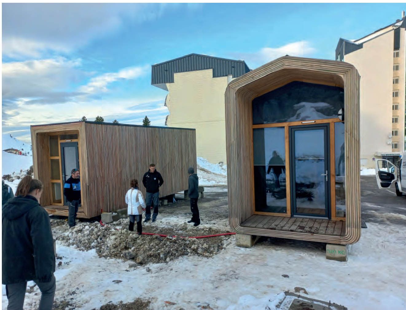
Mugi , projet de village itinérant, écologique, et modulable issu d'une collaboration entre Nobatek/inef4, SOLIHA Pays basque et Inaki Noblia installent ces 2 modules prototypes à la station de ski de la Pierre Saint-Martin, © Nobatek/inef4. Photos de l'installation par Thomas Garnesson et Éma Latapie.
