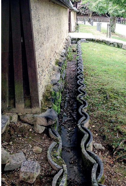
Détail technique d'un fil d'eau en tuile dans la ville de Nara au Japon. © Dimitri Boutleux.
