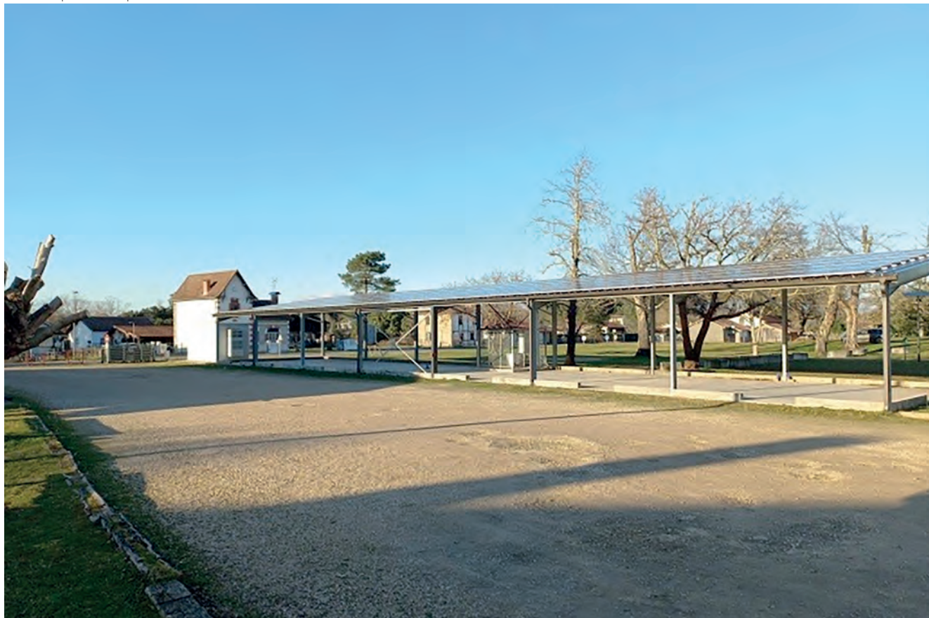
Ombrière photovoltaïque. © Commune d'Escource.
