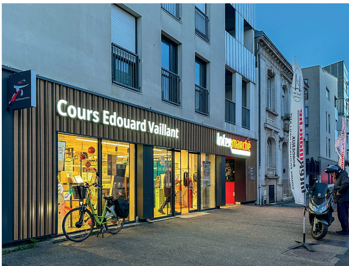
Supermarché de proximité à Bordeaux.
