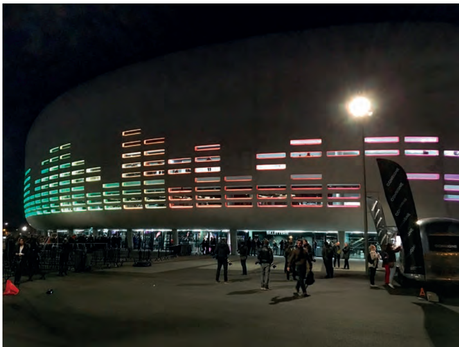
Le galet de béton blanc, signé Rudy Ricciotti, est perforé de baies mises en lumière par un système de LED.
