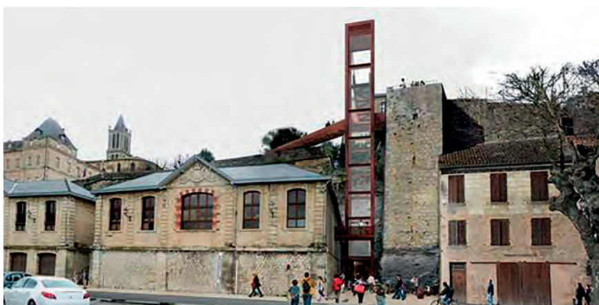
L'ascenseur : brique essentielle d'un projet de réaménagement global.
